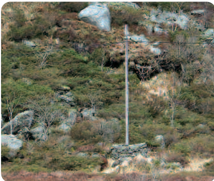
Telefonstolpe på kunstferdig bygd fundament. Foto: Anne-Karin Misje
